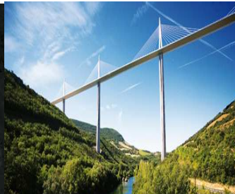
Le Viaduc de Millau record mondial de hauteur 343 mètres et de longueur 2 460 mètres
