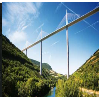
Le Viaduc de Millau record mondial de hauteur 343 mètres et de longueur 2 460 mètres
